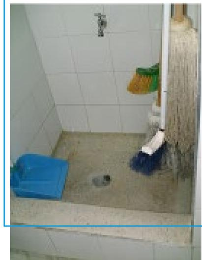
Esta área lleva un desagüe de piso de 3" y un cárcamo con un desagüe de 3" y su rejilla con medidas aproximadas a un metro de frente por 0.30 m de ancho.
