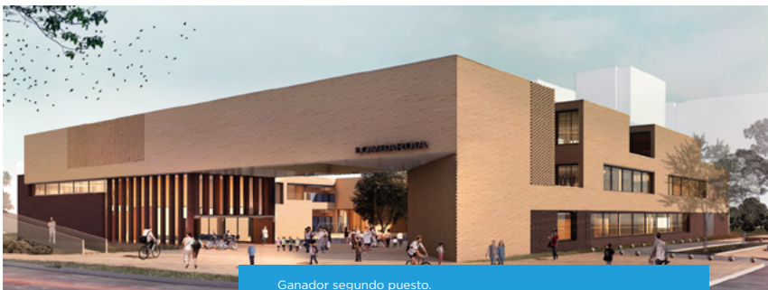
Ganador segundo puesto. Concurso Público Diseño de Anteproyecto Colegio Lombardía, 2018 - Arquitectura en Estudio
