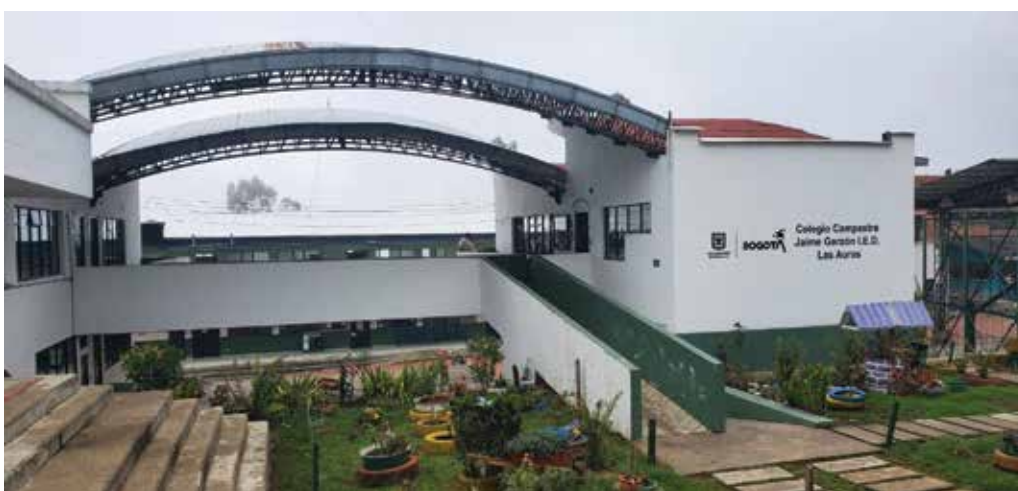
Las obras en el colegio Jaime Garzón- Las Auras incluyeron mejoras en la vivienda docente.
