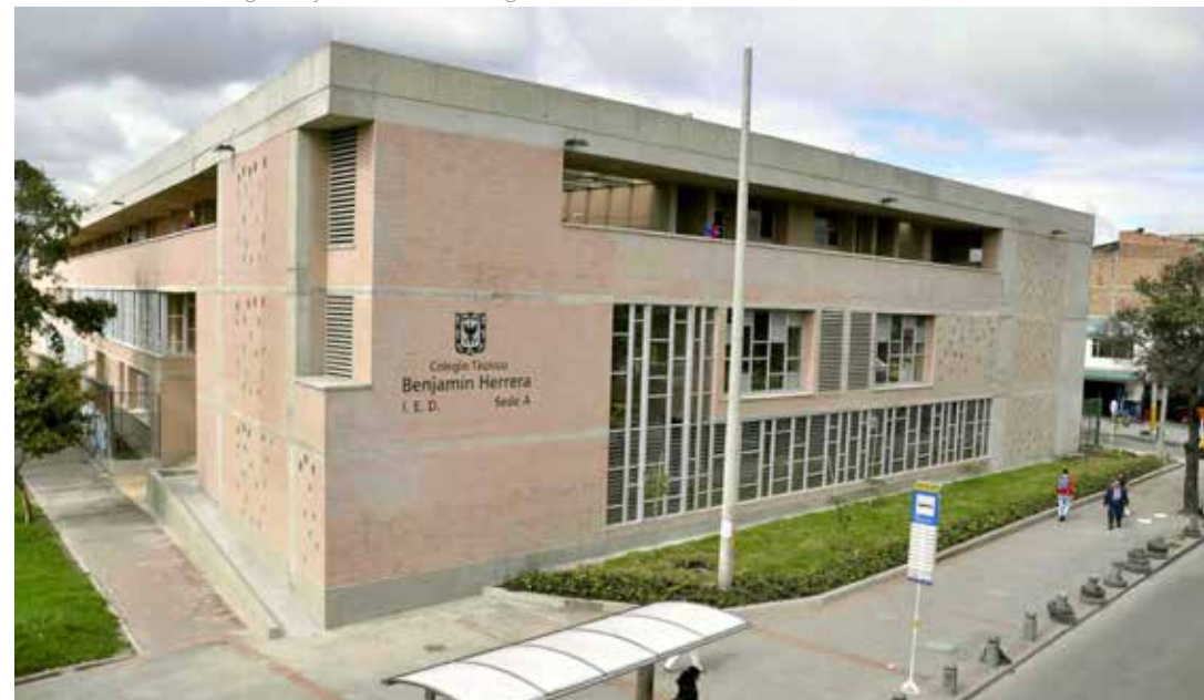
Restitución total del colegio Benjamín Herrera – Fotografía SED
