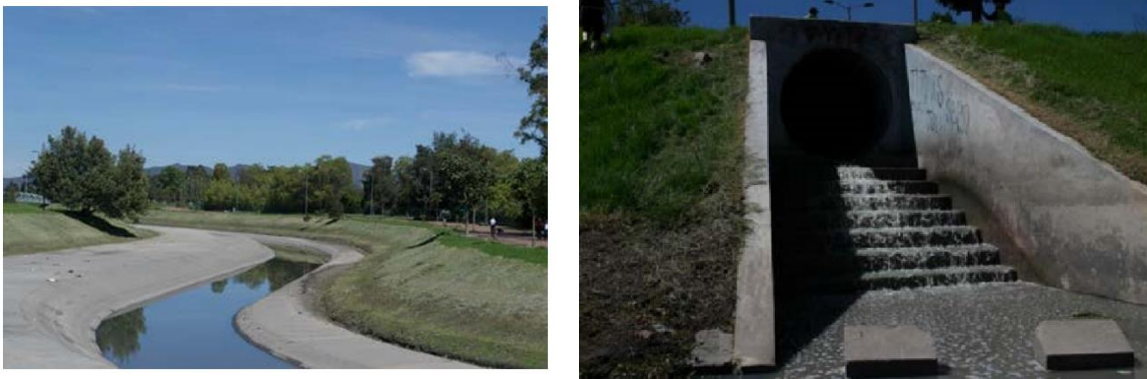
Figura 15 - Intervenciones hidráulicas Río Juan Amarillo
