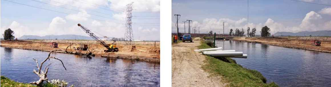
Figura 14 - Intervención jarillones Río Bogotá
