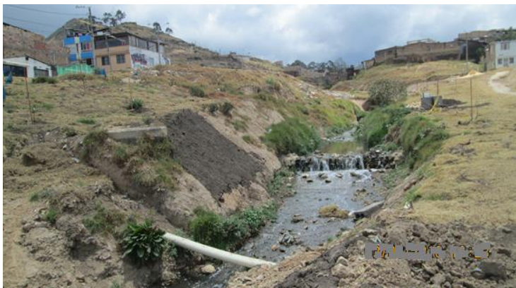
Figura 23 – Recuperación del cauce de la Quebrada Santa Librada
