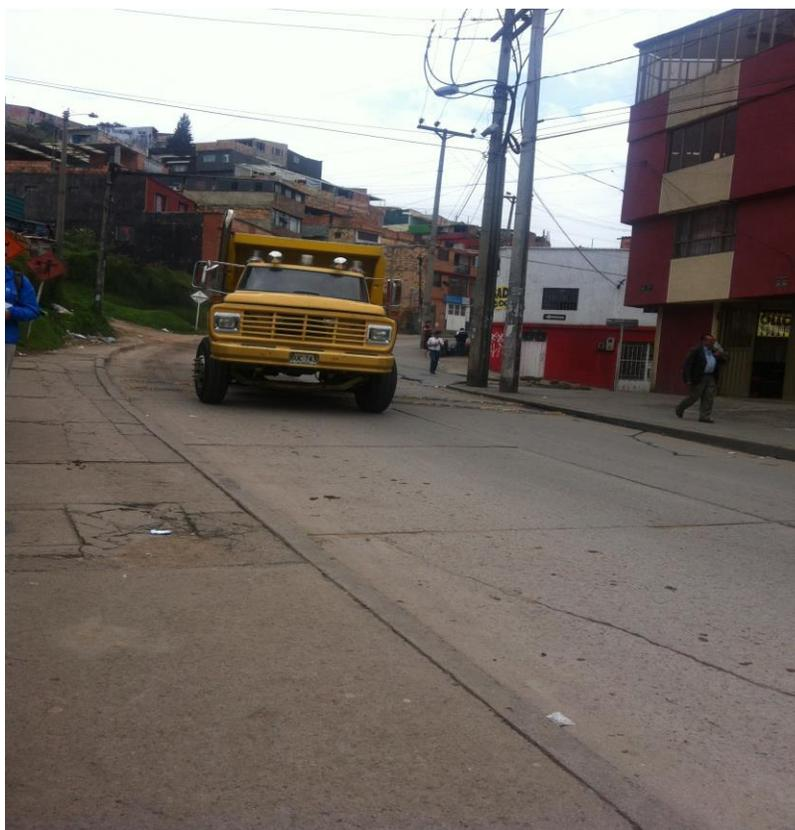
Vía ubicada frente a la **IED Los Alpes** cuyo pavimento presenta deterioro con presencia de reductores de Velocidad que con el tiempo se han dañado. En el otro sentido de circulación NO cuenta con reductores ante lo cual los conductores alcanzan altas velocidades y hay riesgo para el peatón.
